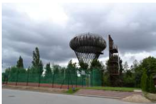
Fot. 11. Wieża ciśnień w Ciechanowie
