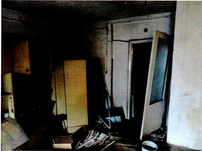
20. ścianki działowe inne pomieszczenie
