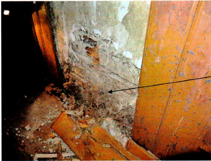
15. Ścianka działowa drewniana na korytarzu (stopień uszkodzenia bali powyżej 50% grubości bali).
