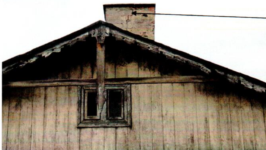
35. komin przy ścianie zewnętrznej od strony południowej
