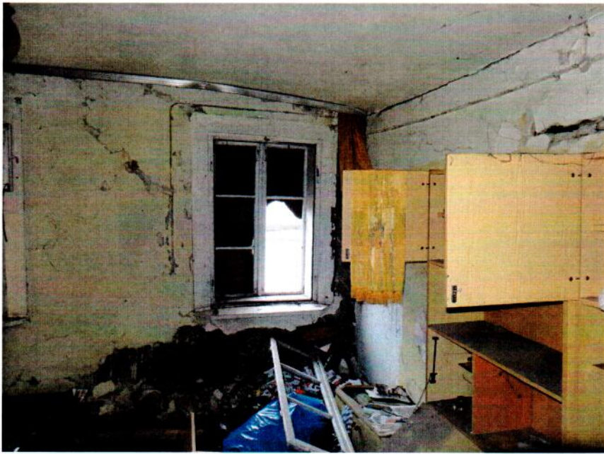
33. Pomieszczenie mieszkalne widok na ścianę zewnętrzną i fragment podłogi
