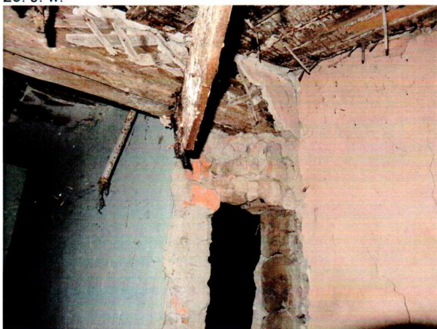
26. Uszkodzenia stropu.
