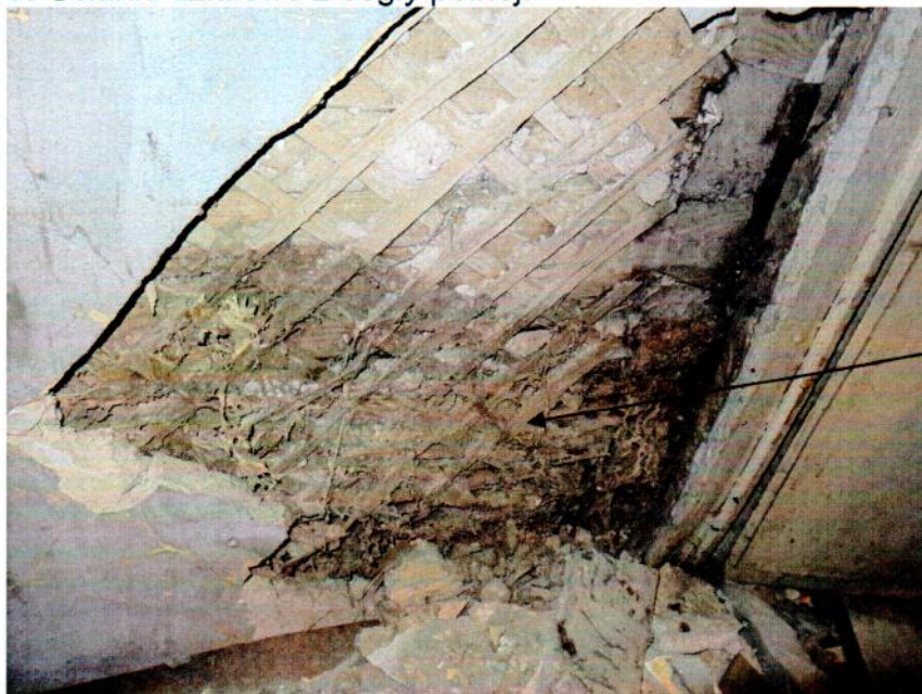
14. Ścianka działowe drewniana (zawilgocenia i spróchnienie bali od strony podłogi)
