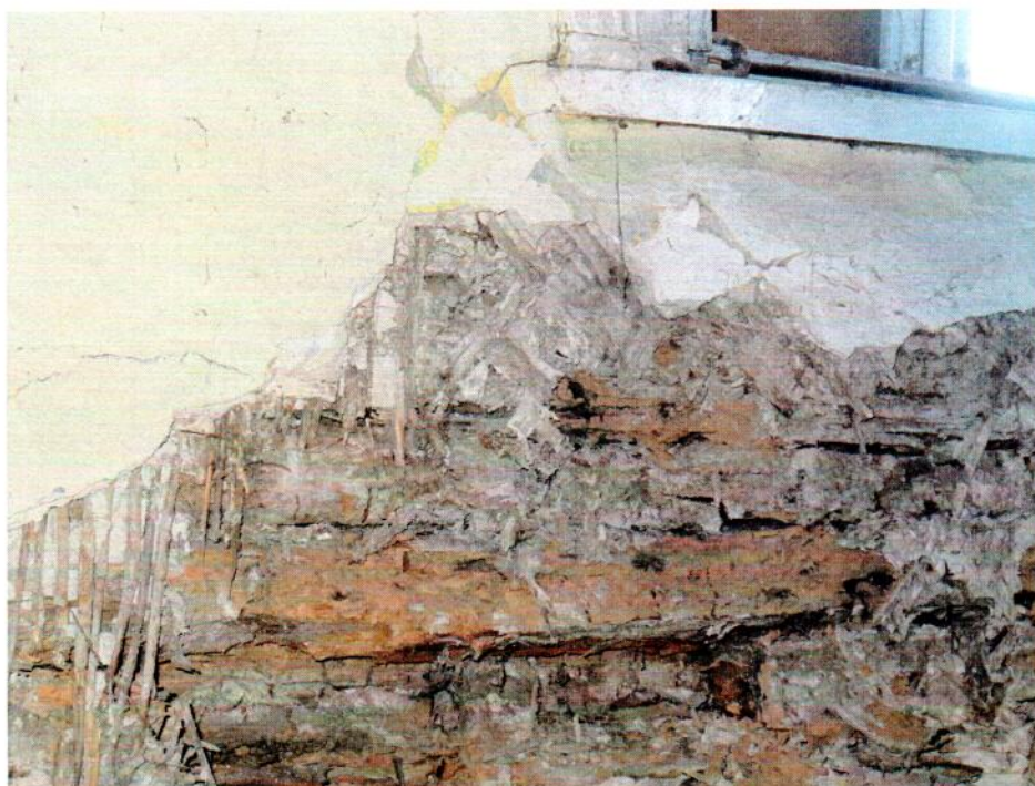
10. J. w. ściana wschodnia
