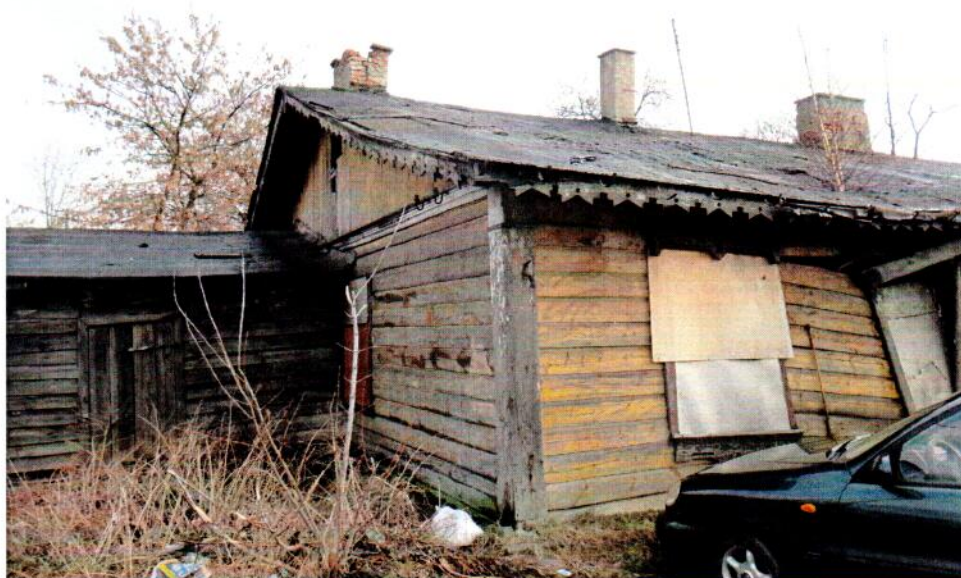
7. Narożnik elewacji północno zachodniej
