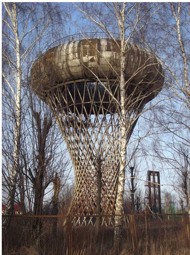
Fot. 1. Widok ogólny konstrukcji wsporczej i zbiornika wyrównawczego
