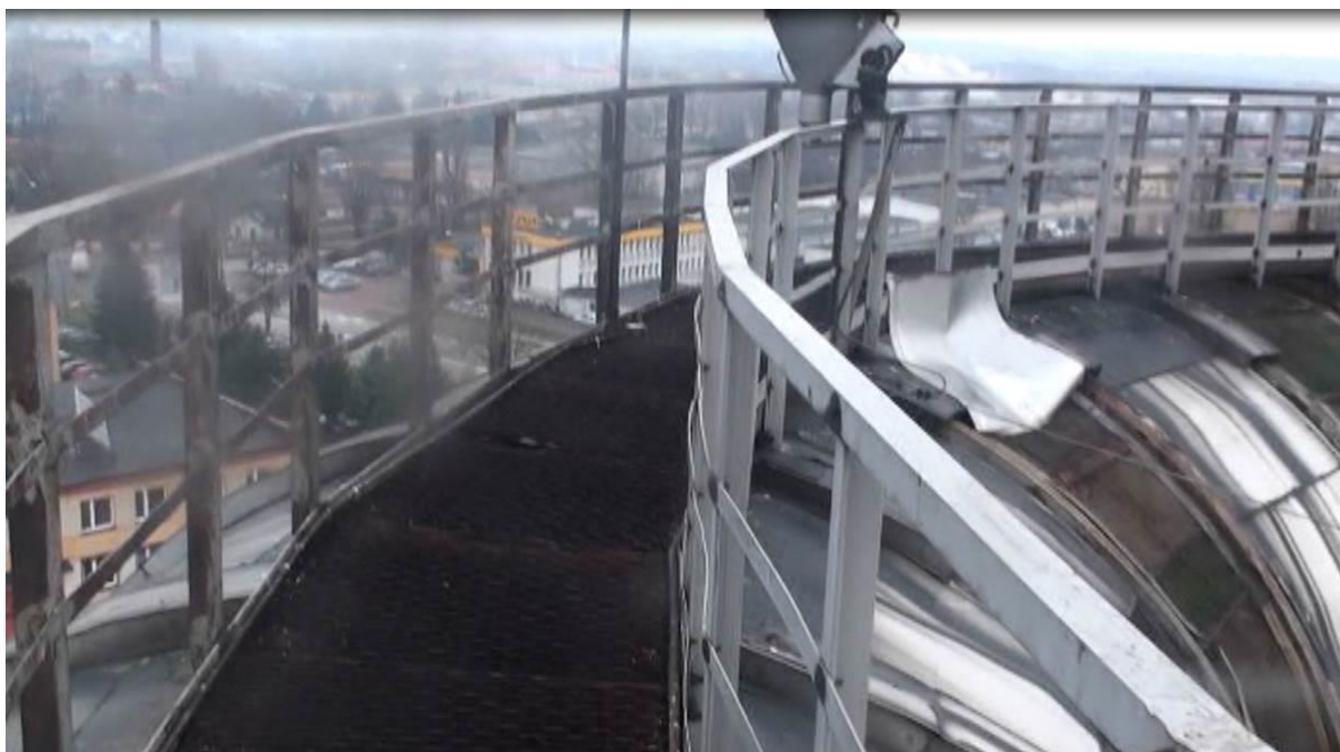
Fot. 15. Barierki chodnika technologicznego: od strony wewnętrznej – bez uszkodzeń korozyjnych, prawdopodobnie wymieniona, od strony zewnętrznej – stara, z uszkodzeniami powłoki malarskiej i ubytkami korozyjnymi
