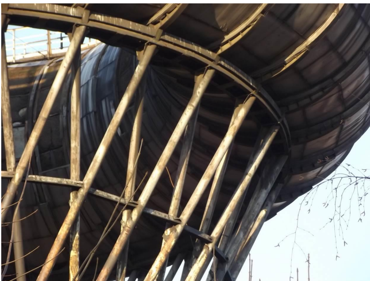
Fot. 13, 14. Oparcie zbiornika wyrównawczego na pierścieniu górnym w poziomie 22,015m nad terenem
