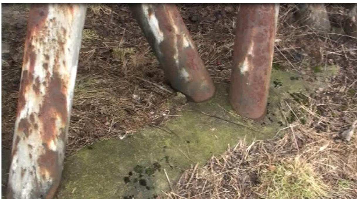
Fot. 27, 28. Główna fundamentu pierścieniowego (por. fot. 35)
