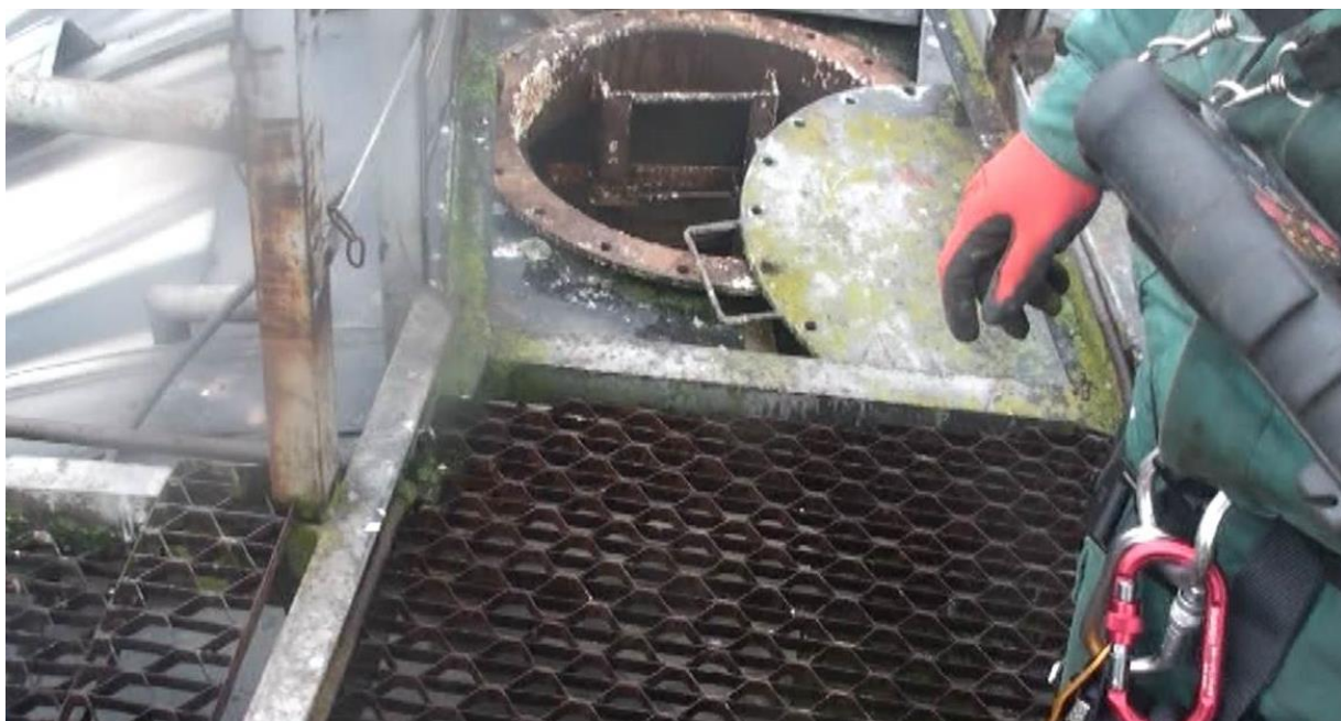
Fot. 9. Chodnik technologiczny na zbiorniku toroidalnym na poziomie 28,658m
