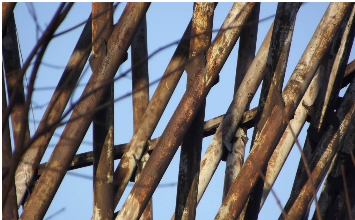
Fot. 25. Typowy stan rur tworzących dwie powłoki hiperboidalne
