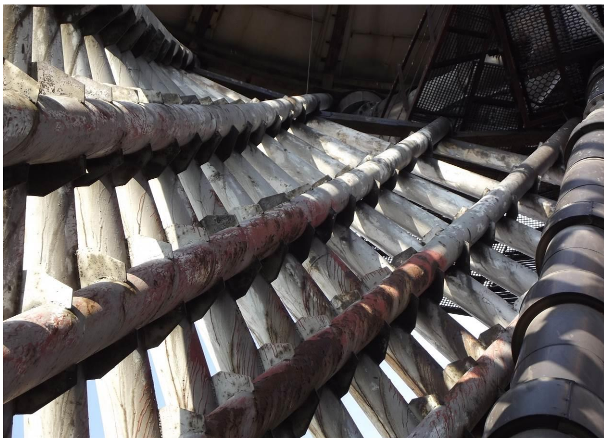
Fot. 33, 34. Krzywoliniowe fragmenty rur tworzących dwupowłokową hiperboloideę
