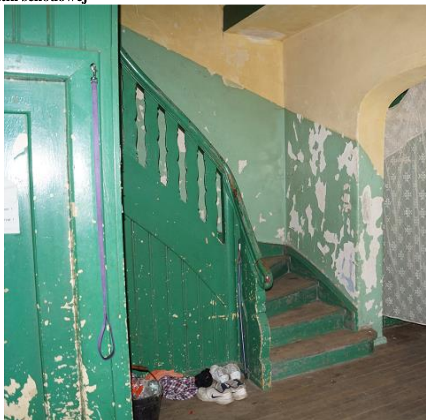
Rys. nr 6. Widok klatki schodowej
