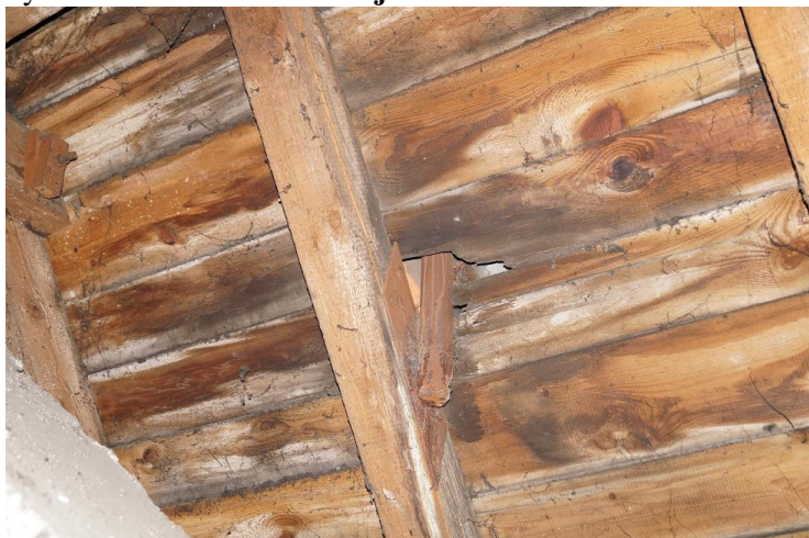
Rys. nr 7. Widok konstrukcji dachu
