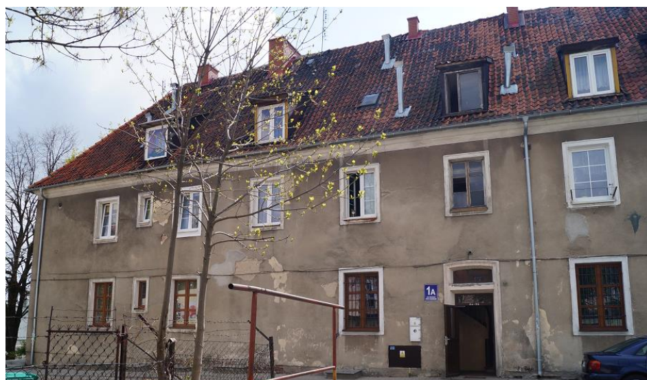
Rys. nr 2. Widok budynku od strony północno-zachodniej
