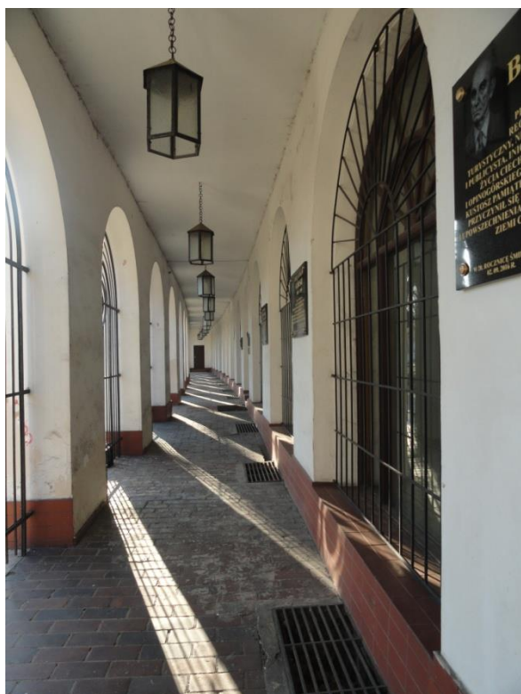
Fot. 5. Elewacja frontowa - podcień
