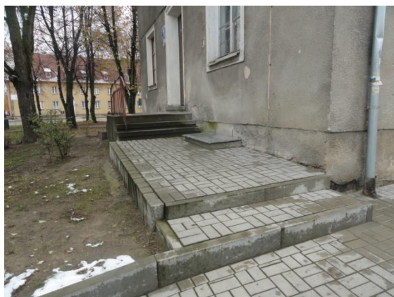
Fot. 2. Elewacja tylna
