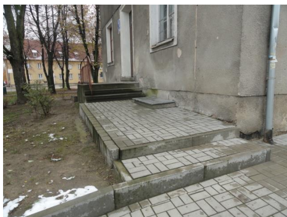
Fot. 2. Elewacja tylna
