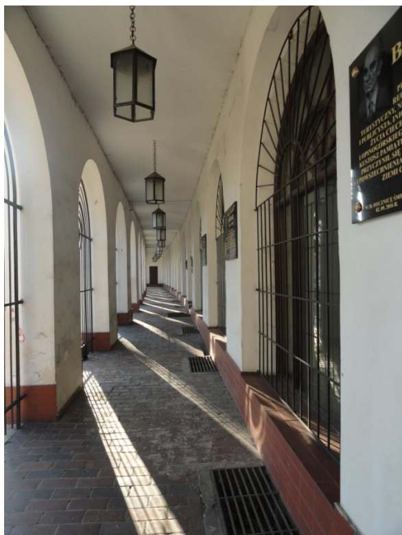
Fot. 5. Elewacja frontowa - podcień
