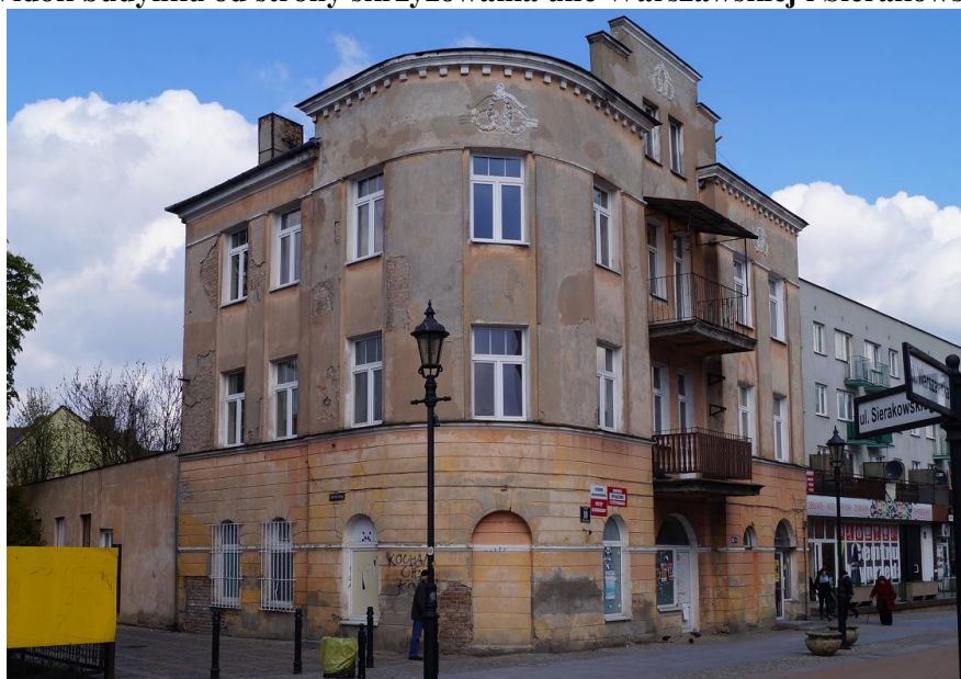
Rys. nr 2. Widok budynku od strony skrzyżowania ulic Warszawskiej i Sierakowskiego
