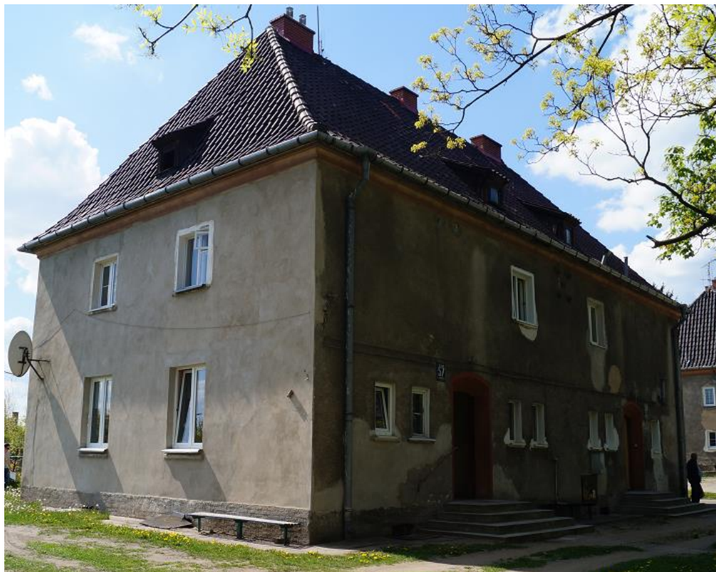
Rys. nr 3. Widok budynku od strony południowej
