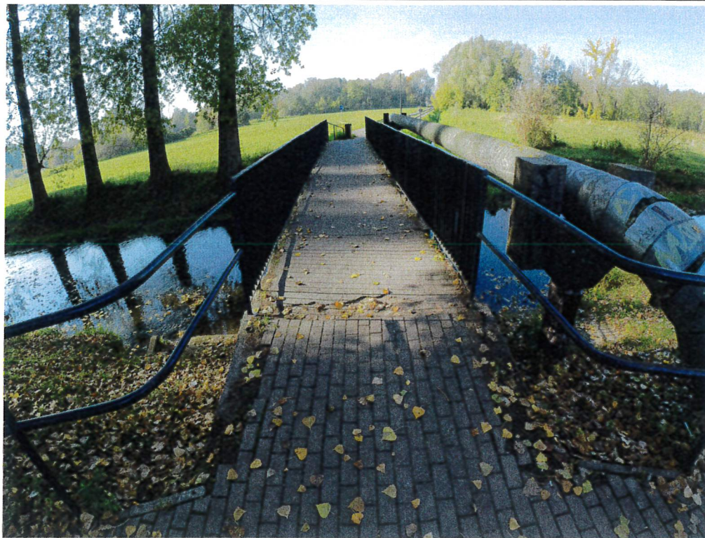
Fot. 1. Widok ogólny na kładkę dla pieszych
