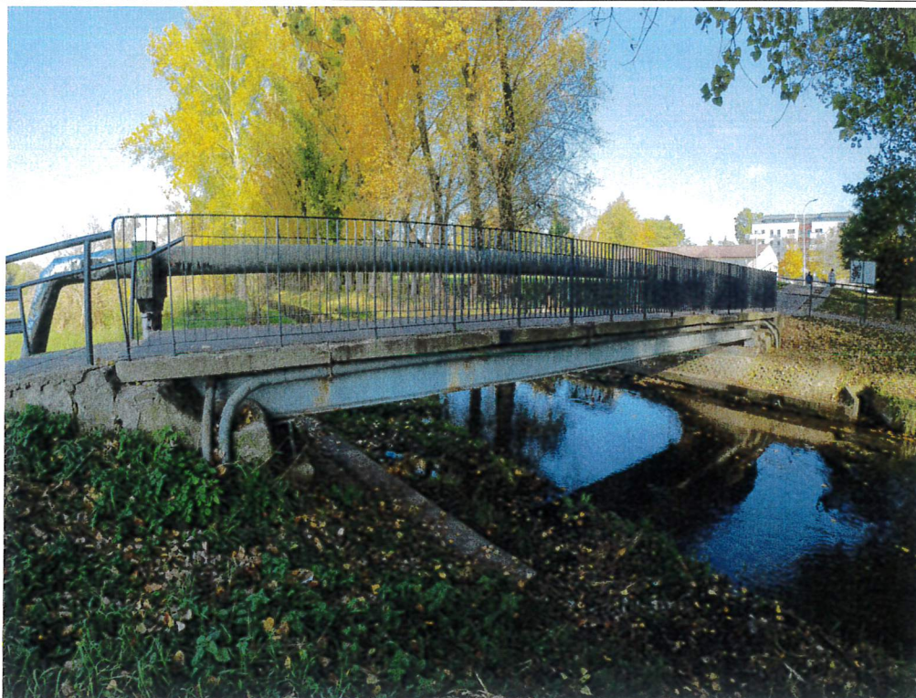
Fot. 3. Widok boczny na obiekt
