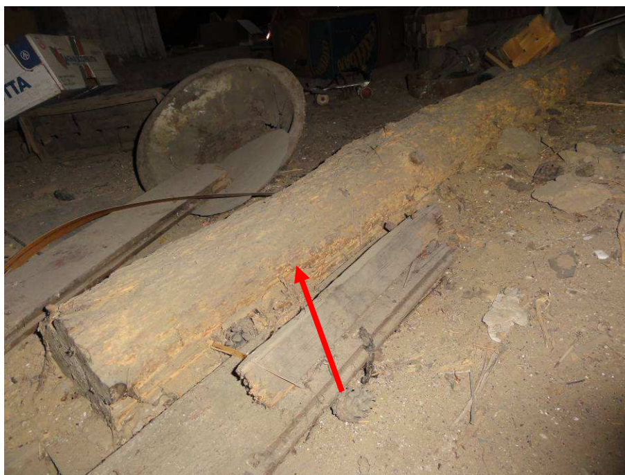
Fot. 39 Element głównej płatwi stopowej silnie osłabiony poprzez działanie drewno jadów (Spuszczela pospolitego). Żerowiska nieaktywne.
